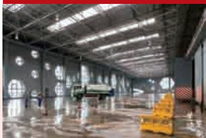
▲ 生活垃圾运输车经地磅称重后由上料坡道进入卸料大厅，将垃圾卸入垃圾仓
