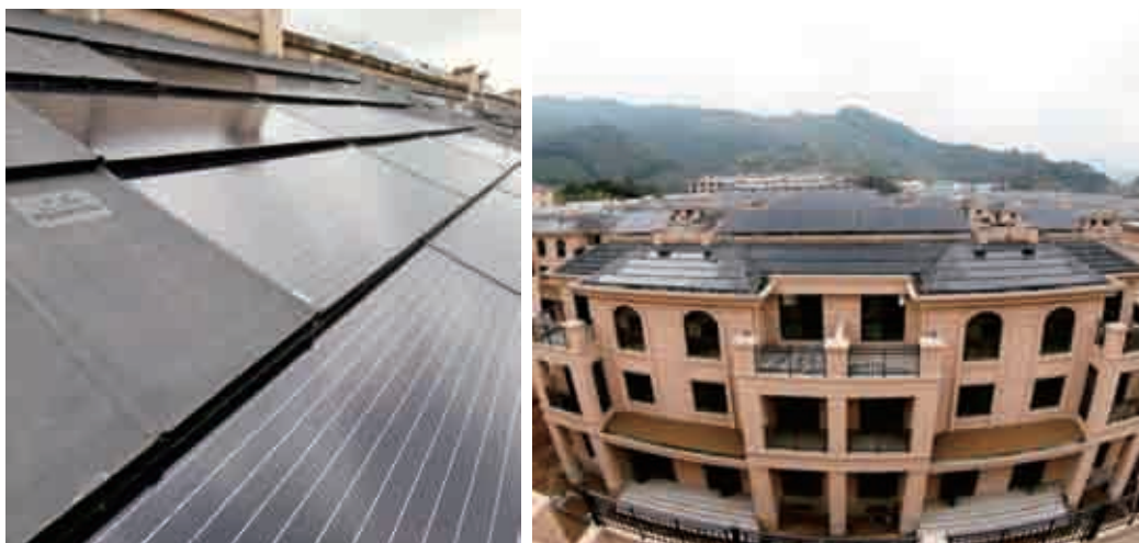
图3-5-2光伏瓦安装效果图
