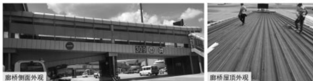
图4 309廊桥（廊桥原型）
